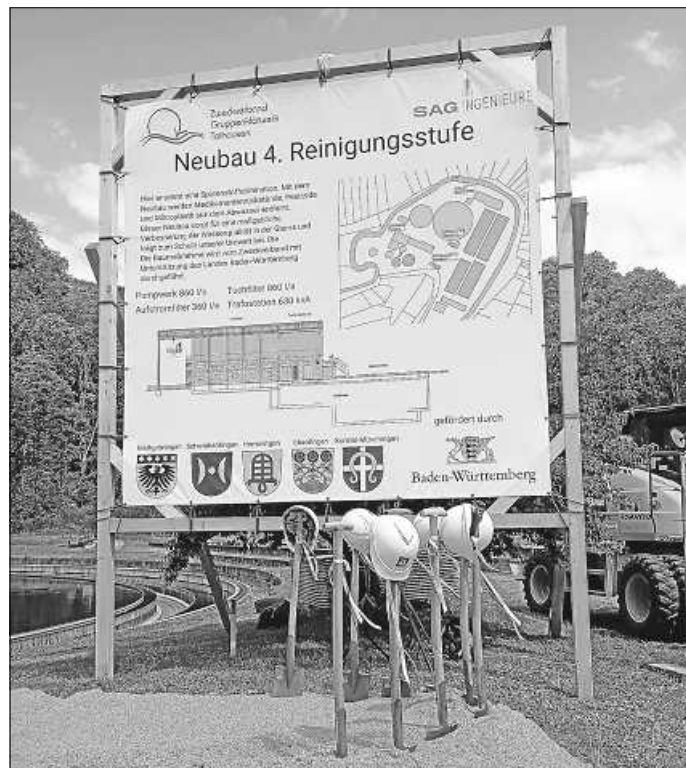
Infoplakat zum Neubau der vierten Reinigungsstufe Foto: SJ
