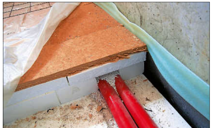
Auch über undichte Rohrdurchführungen kann Hitze ins Gebäude dringen. Foto: KEA
