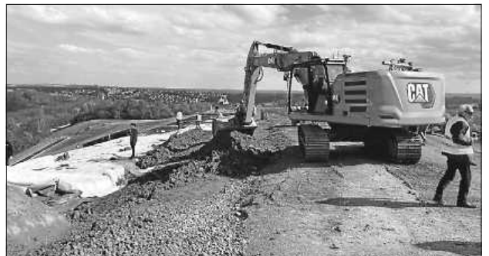
Auffüllarbeiten auf dem Froschgraben
