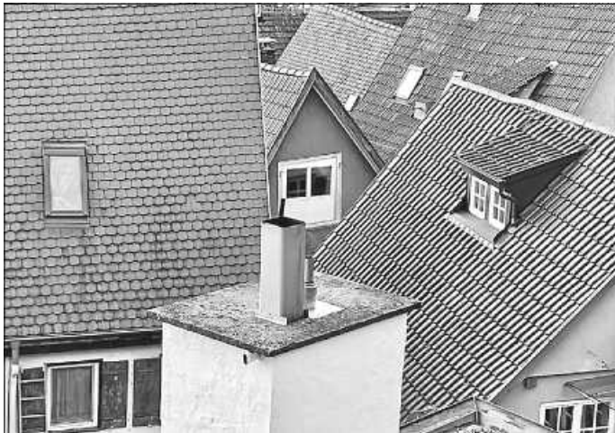
Klimaschädliches CO 2 aus dem Schornstein gehört zukünftig der Vergangenheit an. Foto: LEA
