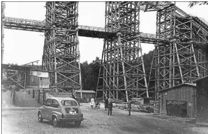
Baugerüst Glemstalviadukt
