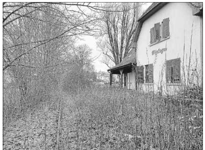
Der stillgelegte Möglinger Bahnhof wird eine der Haltestellen der Stadtbahn. Fotos: (c): Zweckverband Stadtbahn
