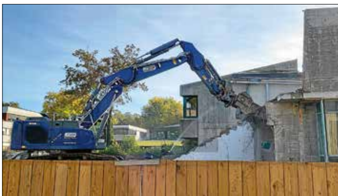
Die Abbrucharbeiten am Anbau des Bestandsgebäudes der Glemstalschule laufen auf Hochtouren.
